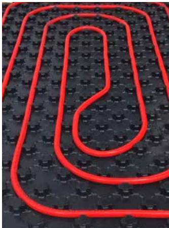
1. Verlegung von SYMPOR Unisolo 14-17 auf sauberem Untergrund Einlegen der Fußboden-Heizungsrohre
