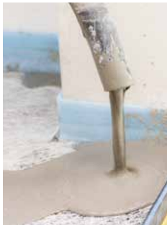
5. Aufbringung von Dünnestrich UZIN NC 195
