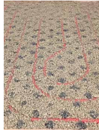
3. Plan abziehen von SYMPOR-LB 400 (oder SYMPOR-LB 400 S) direkt an der Noppenoberkante
