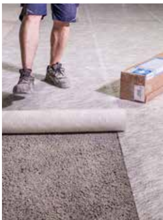
4. Verlegung von Renoviervlies UZIN RR 201 mit 2 cm Überlappung
