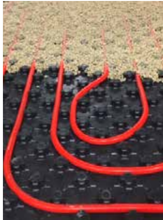
2. Verfüllen der Noppen-Zwischenräume mit SYMPOR-LB 400 (oder SYMPOR-LB 400 S)
