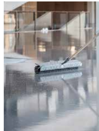
6. Dünnestrich UZIN NC 195 mit ca. 8 mm Dicke auftragen
