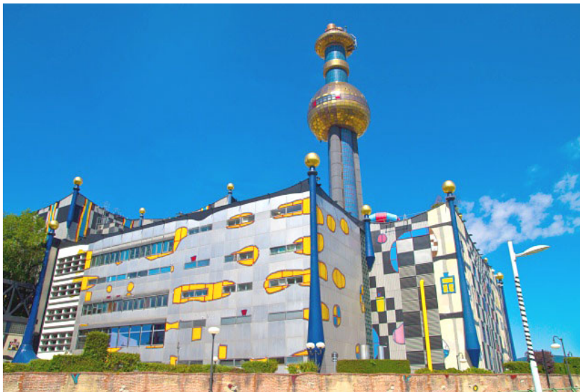
Foto: Müllverbrennungsanlage Spittelau (© MA 20 / Steven Duchon)
