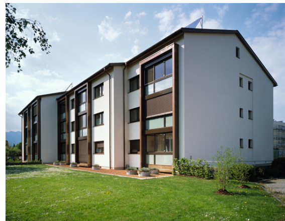
Foto: Wohnanlage Rankweil-Schleipfweg nach Sanierung
